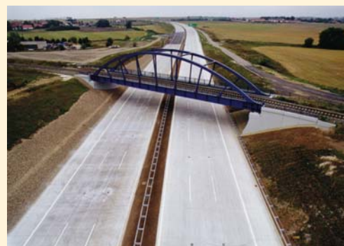
Stavba 516 Třebonice – Řepy před otevřením Zdroj: ŘSD ČR
