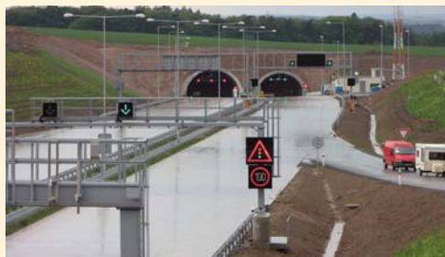
Stavba 513 Cholupické portály
