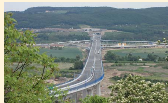
Stavba 514 Estakáda přes údolí Berounky
