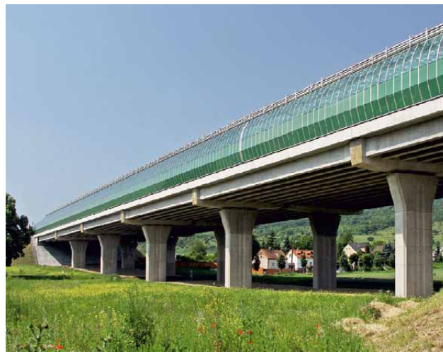
143 Dálnice D8, most Vchýnice
