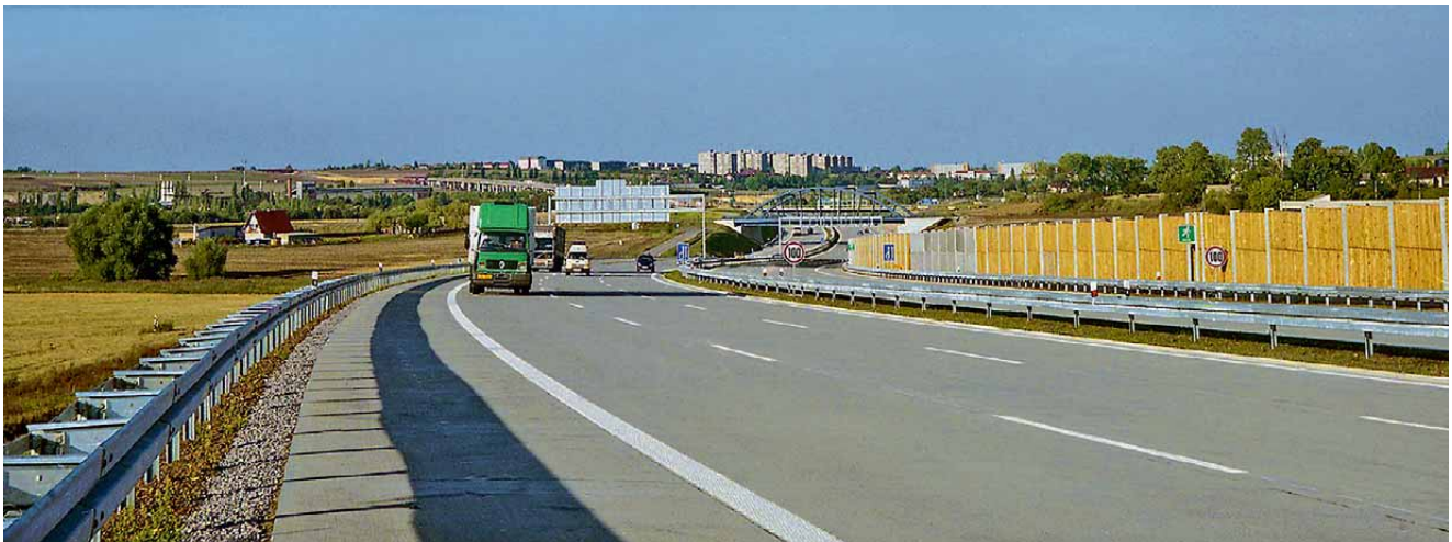
85 Silniční okruh kolem Prahy, stavba 516 Třebonice – Řepy
