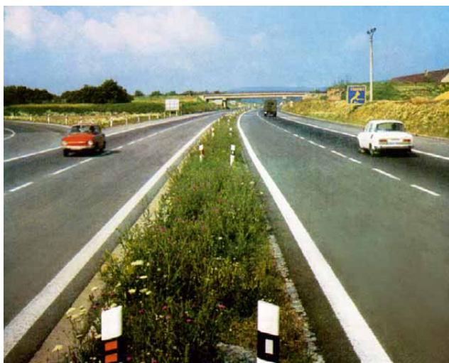
15 Přeložka silnice I/4 mimo Řitku
