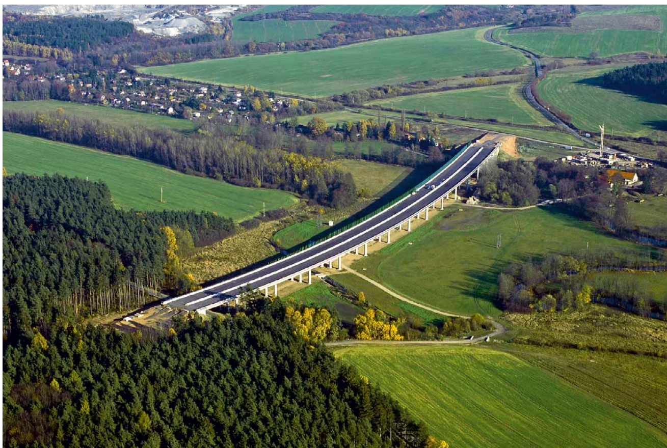
84 Dálnice D5, most přes řeku Úslavu před dokončením navazujících staveb
