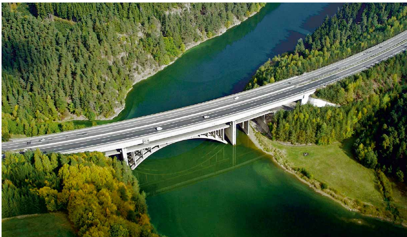
24 Dálnice D1, most Pišť přes vodní nádrž Švihov v km 76,5, celková délka 229 m. Most je tvořen ocelovou spojitou konstrukcí o třech polích v délce 66 + 92,5 + 66 m.
