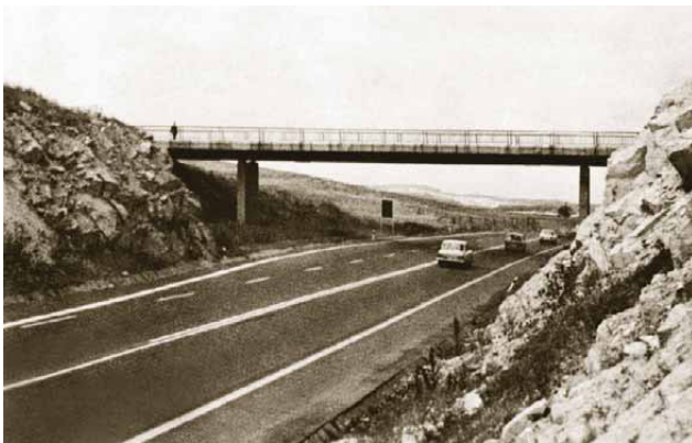
20 Rekonstrukce silnice I/6 u Žalmanova
