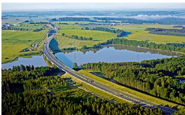
160 Dálnice D3, most přes rybník Koberný
