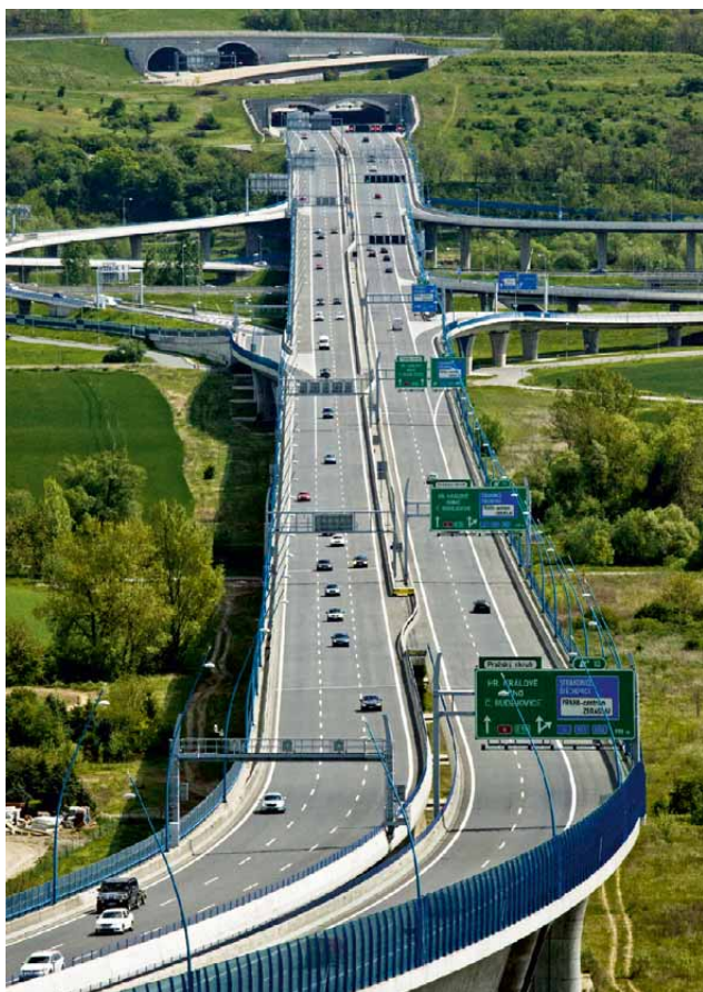
164 Dálnice D0, stavba 513 a 514, MÚK Lahovice
