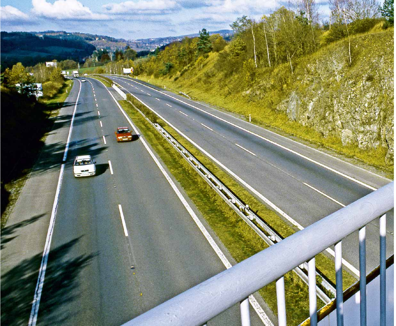
9 Dálnice D1, stavba 005 Mirošovice – Šternov
