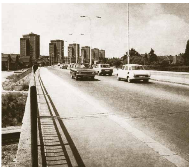
26 Rekonstrukce silnice II/238 v Kladně
