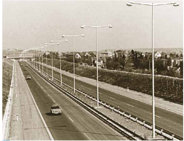
31 Rozvadovská spojka ve Stodůlkách
