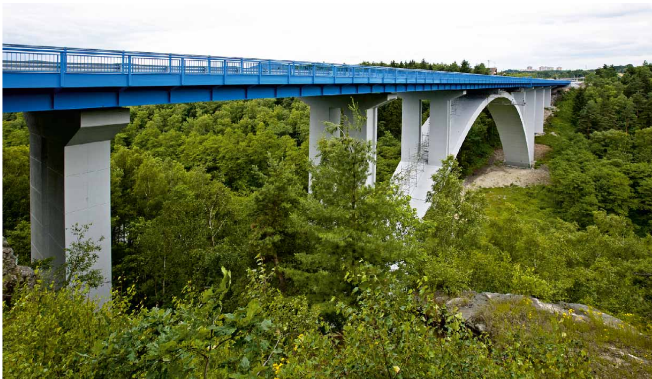
33 Most přes řeku Ohři na přeložce silnice I/6
