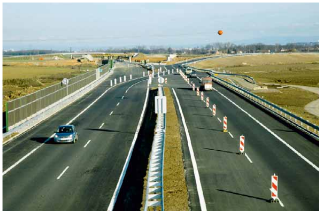
117 Dálnice D11, provizorní ukončení v místě budoucí MÚK Sedlice
