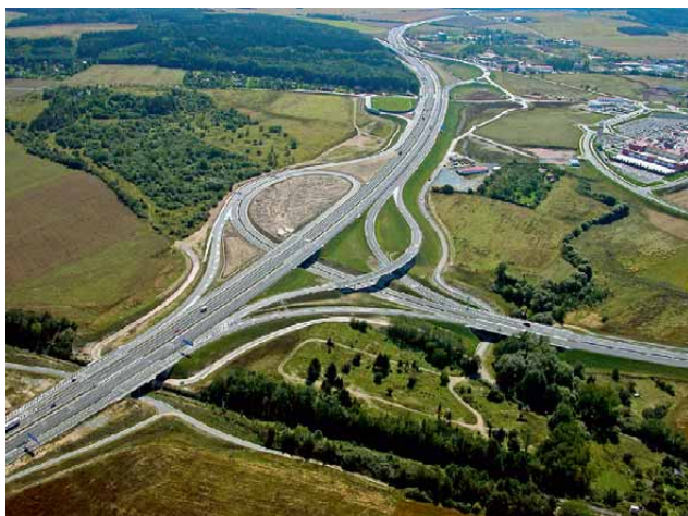
89 Dálnice D5, křižovatka Plzeň-centrum se silnicí I. tř. č. 20
