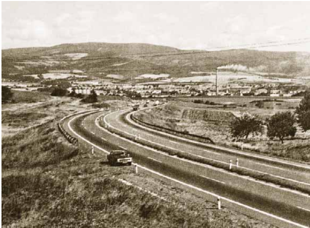
18 Přestavba silnice I/13 Lesov – Ostrov
