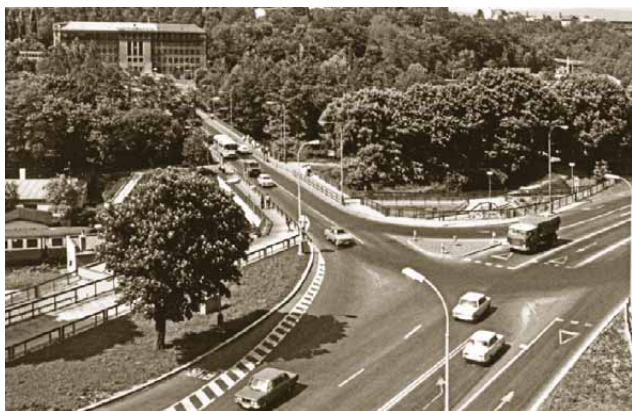
67 Rekonstrukce křižovatky na náměstí Republiky v Karlových Varech
