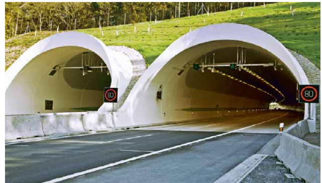
133 Dálnice D5, tunel Valík – západní portály
