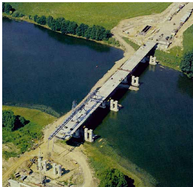
83 Segmentový most přes vodní nádrž Skalka u Chebu
