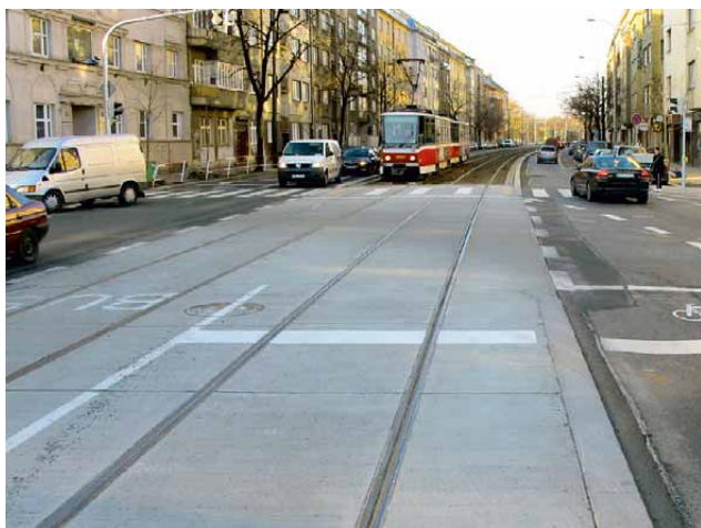
152 153 Rekonstrukce tramvajové trati ve Vršovické ulici v Praze
