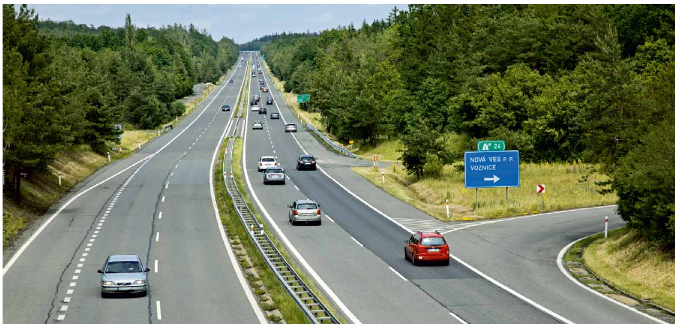
11 Rychlostní silnice R10, úsek Řitka – Mníšek – Voznice
