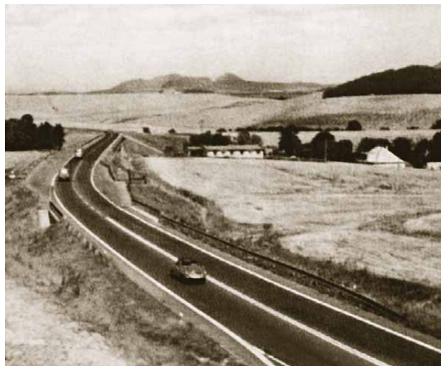
16 Rekonstrukce silnice I/7 u Chlumčan
