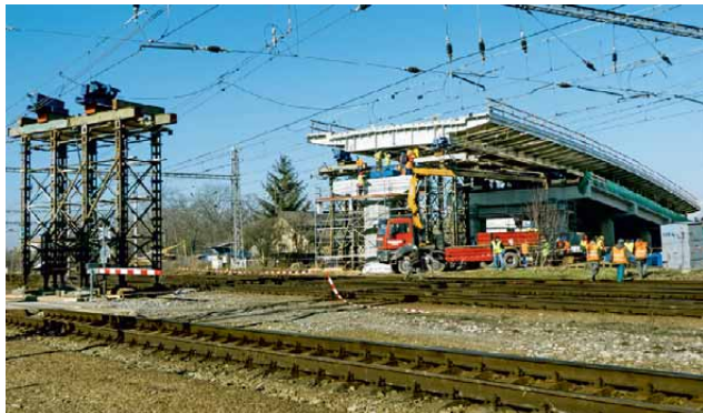
156 158 II/272 Lysá nad Labem, rekonstrukce mostu přes trať
