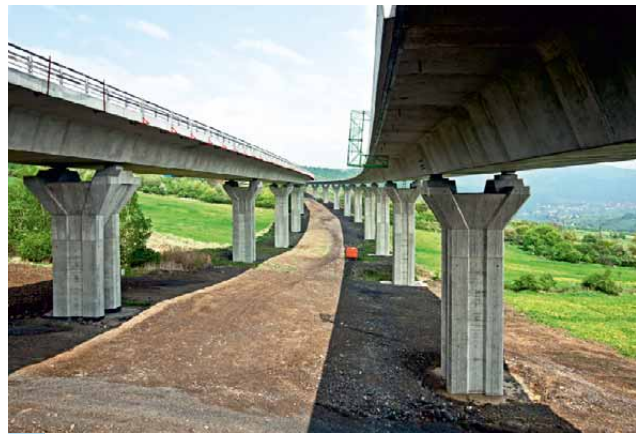
130 Dálnice D8, stavba 805 estakáda Prackovice
