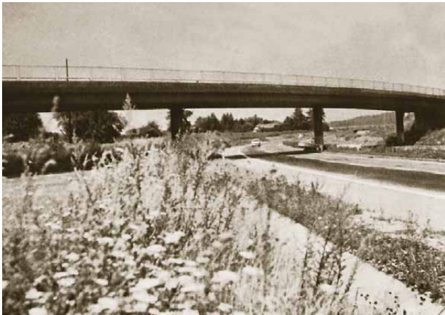
4 Přeložka silnice I/4 u Jiloviště s nadjezdem
