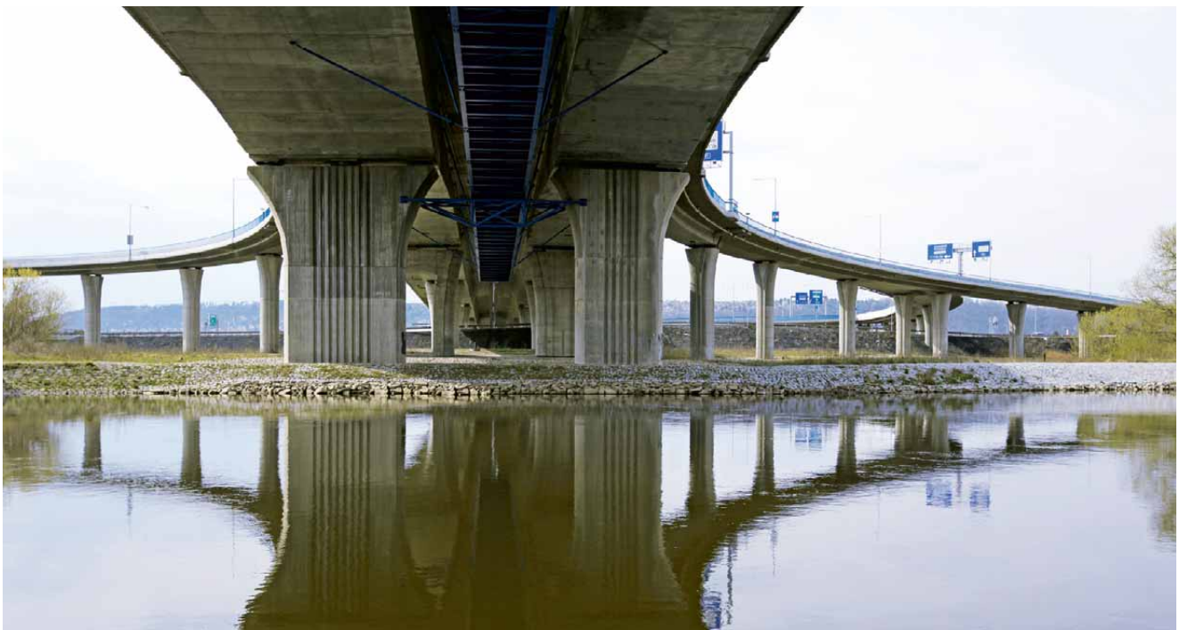
126 Silniční okruh kolem Prahy, stavba 513 Vestec – Lahovice, most přes Vltavu
