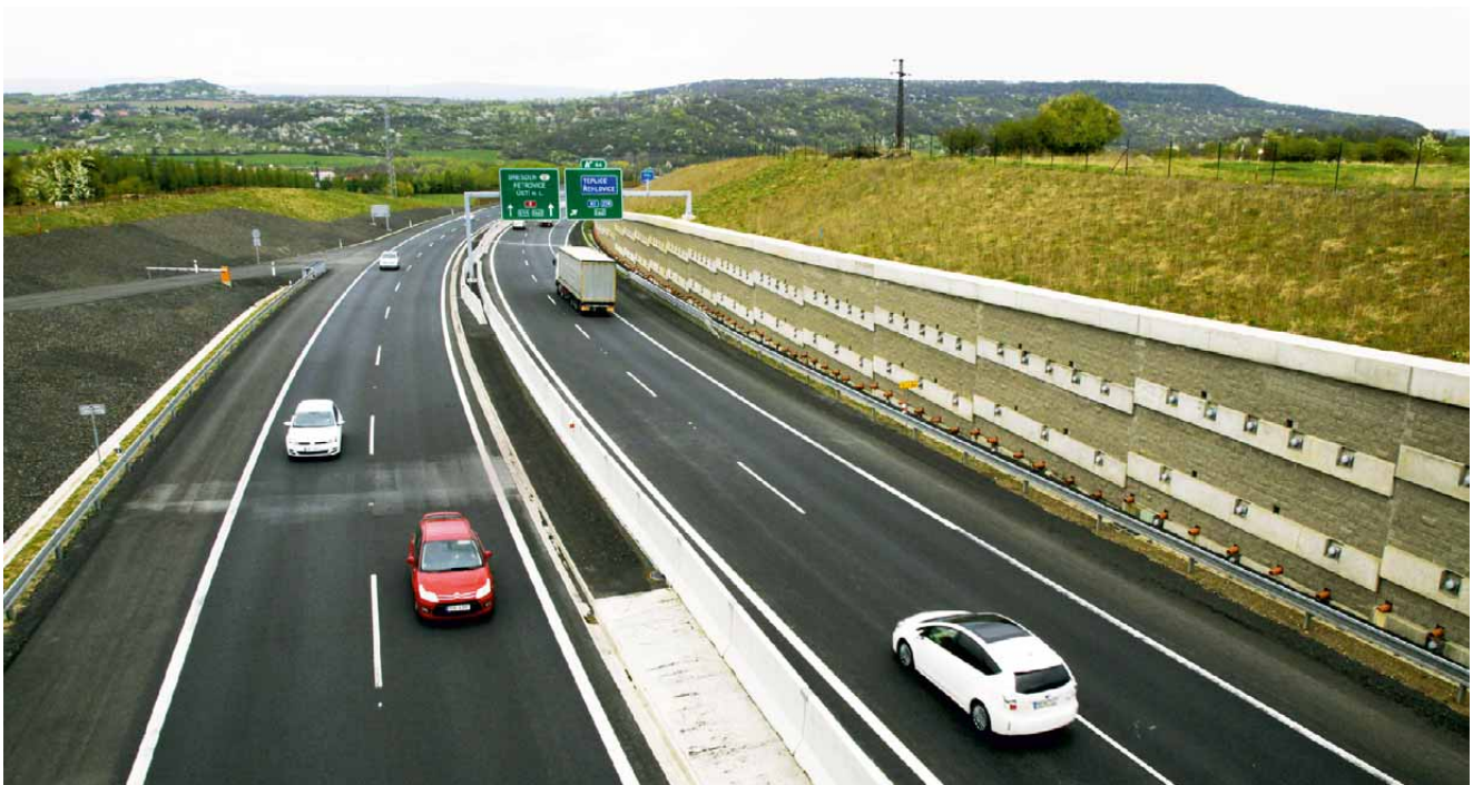
115 Dálnice D8, stavba 0805 u Řehlovic
