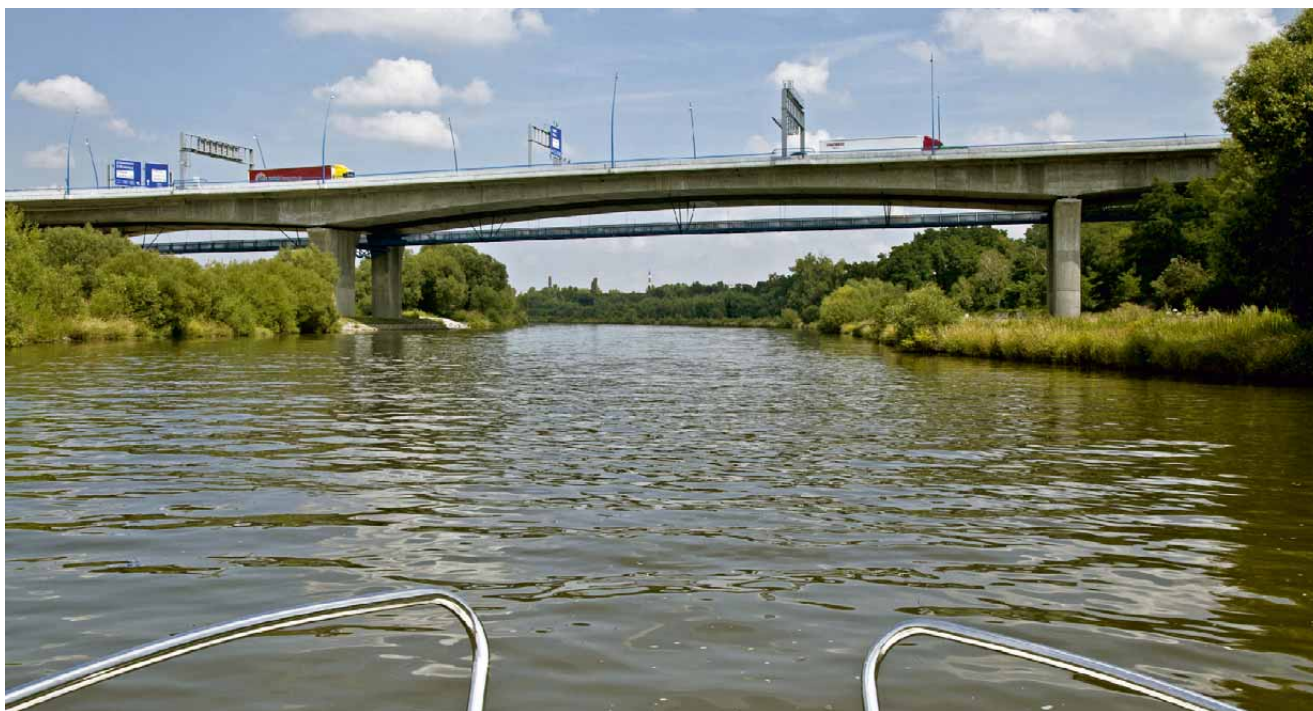
110 Silniční okruh kolem Prahy, stavba 513 Vestec – Lahovice
