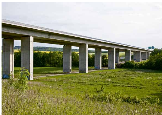
93 Dálnice D5, most přes Úslavu
