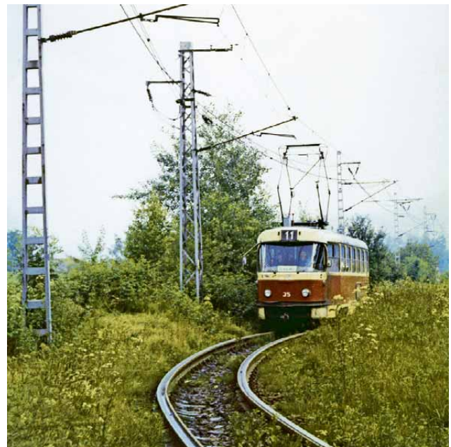
41 Rekonstrukce tramvajové trati Liberec – Jablonec nad Nisou
