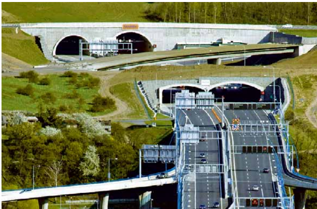
132 Silniční okruh kolem Prahy, stavba 513 Lahovice – Vestec, tunel Komořany
