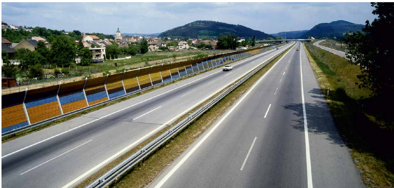
68 Dálnice D5 u Zdic
