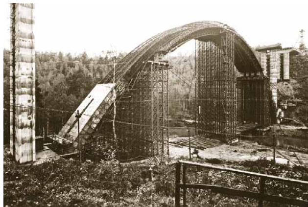
34 Výstavba mostu přes řeku Ohři na přeložce silnice I/6
