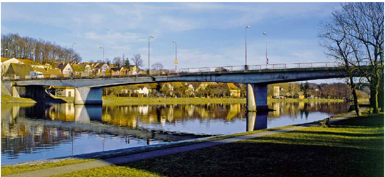
5 Silnice I/23, most přes Vltavu v Týně nad Vltavou
