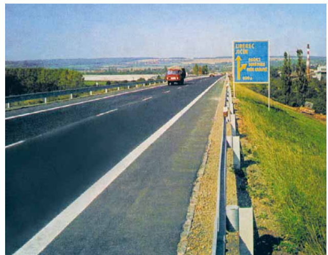
22 Přeložka silnice I/35 v Hořicích, I. a II. etapa
