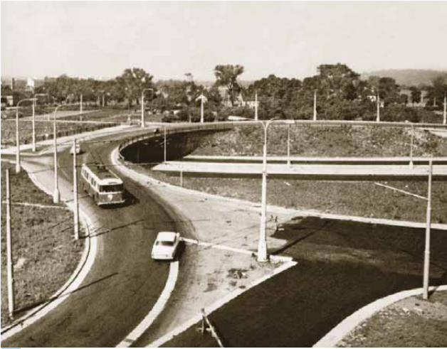
29 Mimoúrovňová okružní křižovatka na přeložce silnice I/27 u Pekla v Plzni
