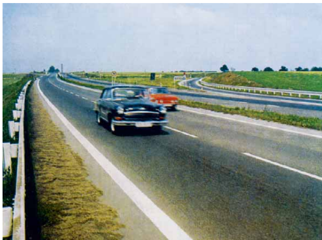
23 Mimoúrovňová křižovatka Koničkův mlýn na přeložce silnice I/7
