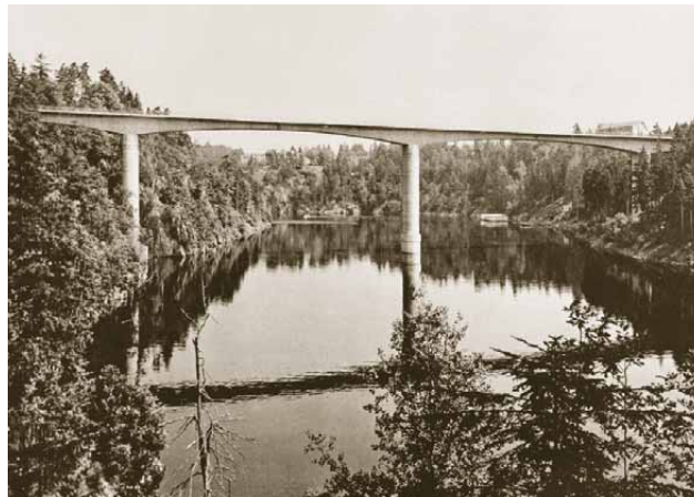
3 Most přes řeky Vltavu a Otavu u Zvíkova o celkové délce 252 m a rozpětí 48 + 84 + 84 + 48 m
