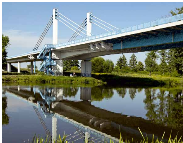
137 Silnice I/38, most přes Labe u Nymburka
