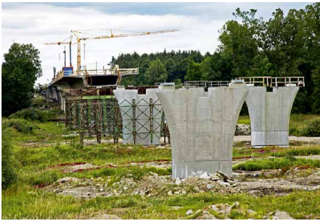
128 Dálnice D3, estakáda u Veselí nad Lužnicí
