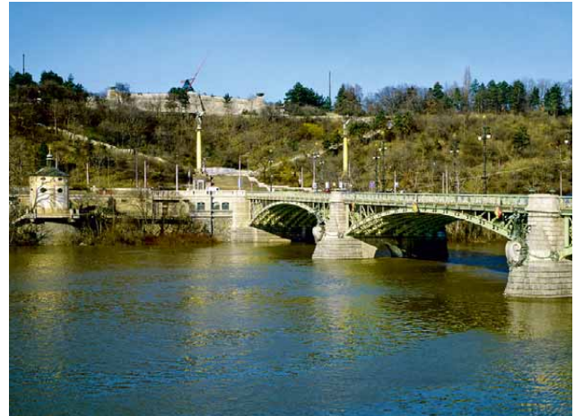
37 Rekonstrukce Čechova mostu v Praze
