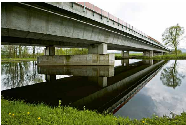
73 Rychlostní silnice R10, most přes Jizeru u Svijan
