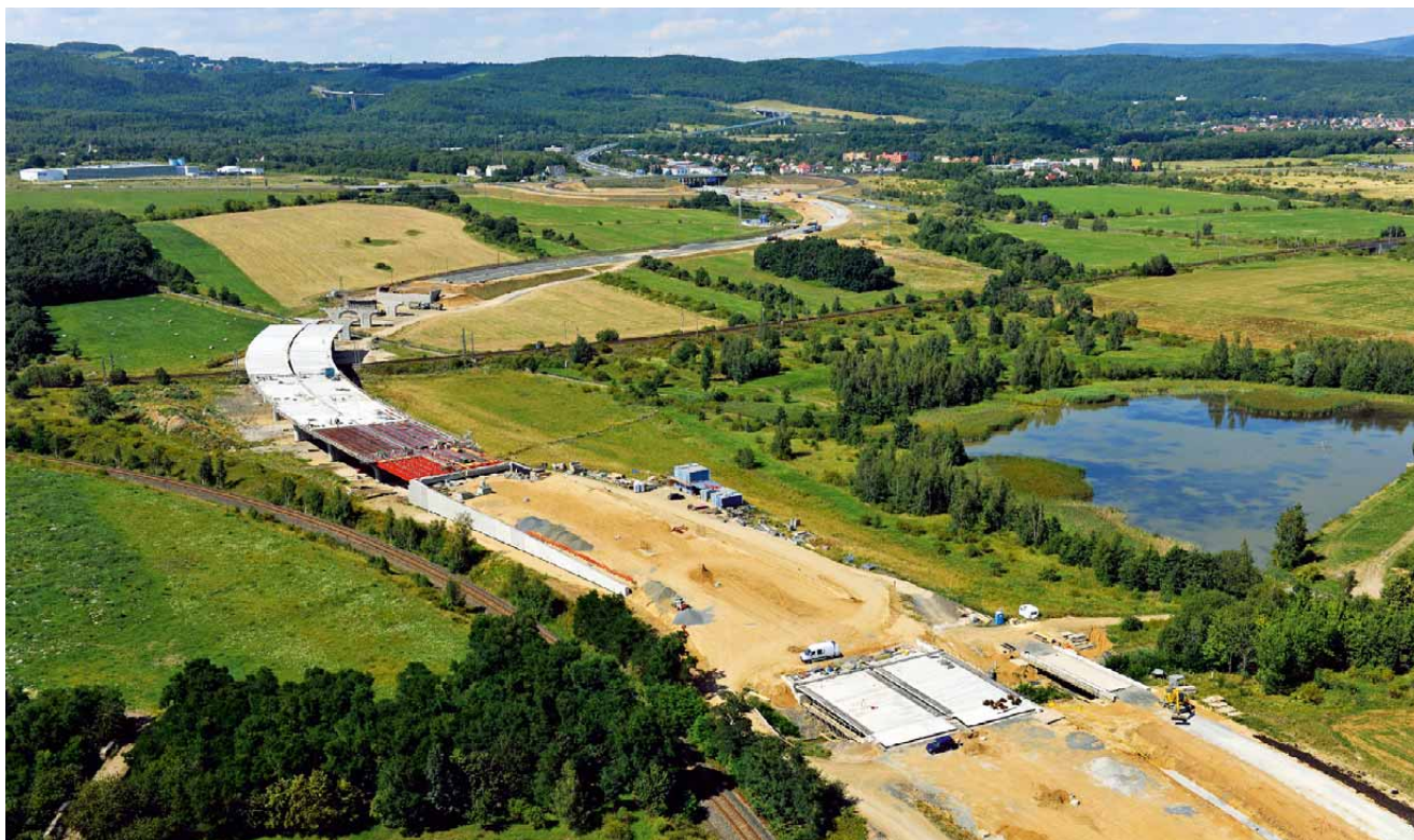
112 Rychlostní silnice R7, stavba MÚK Droužkovice – MÚK Nové Spořice
