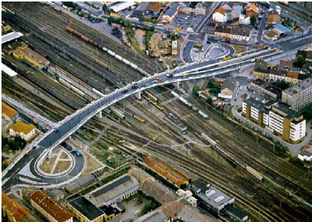
131 Plzeň, přemostění přes trať ČD U Prazdroje
