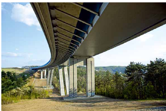
159 Silniční okruh kolem Prahy, stavba 514, most Lahovice – Slivenec
