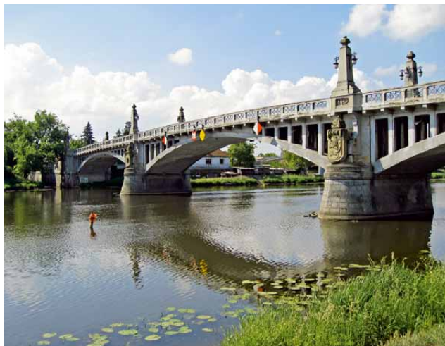
136 Silnice II/503, Nymburk, most přes Labe
