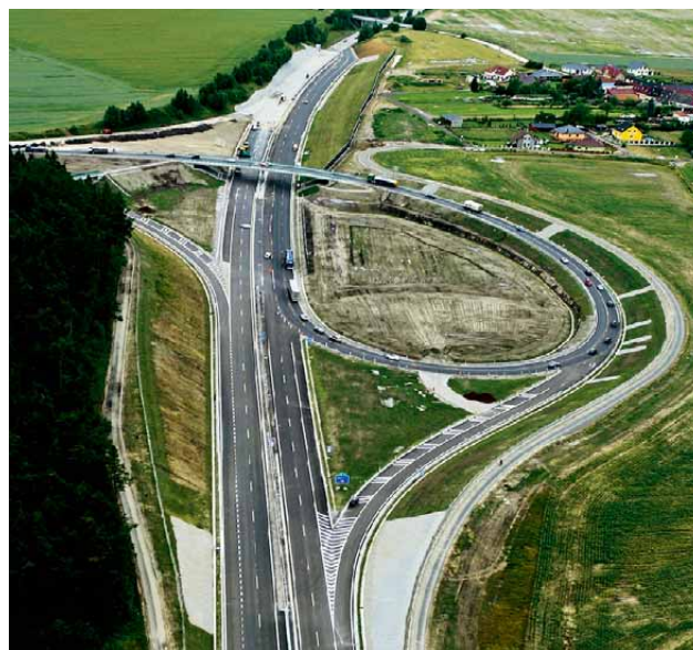
142 Dálnice D3, MÚK Veselí nad Lužnicí
