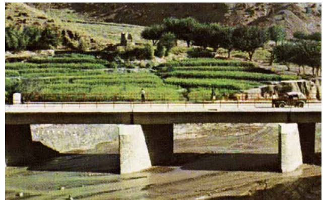
52 Mostní objekt v Afganistanu, na kterém Pragoprojekt prováděl v letech 1968–1969 supervizi.
