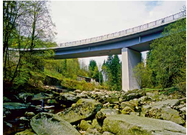
8 Přeložka silnice I/10, most přes řeku Jizeru u Kořenova
