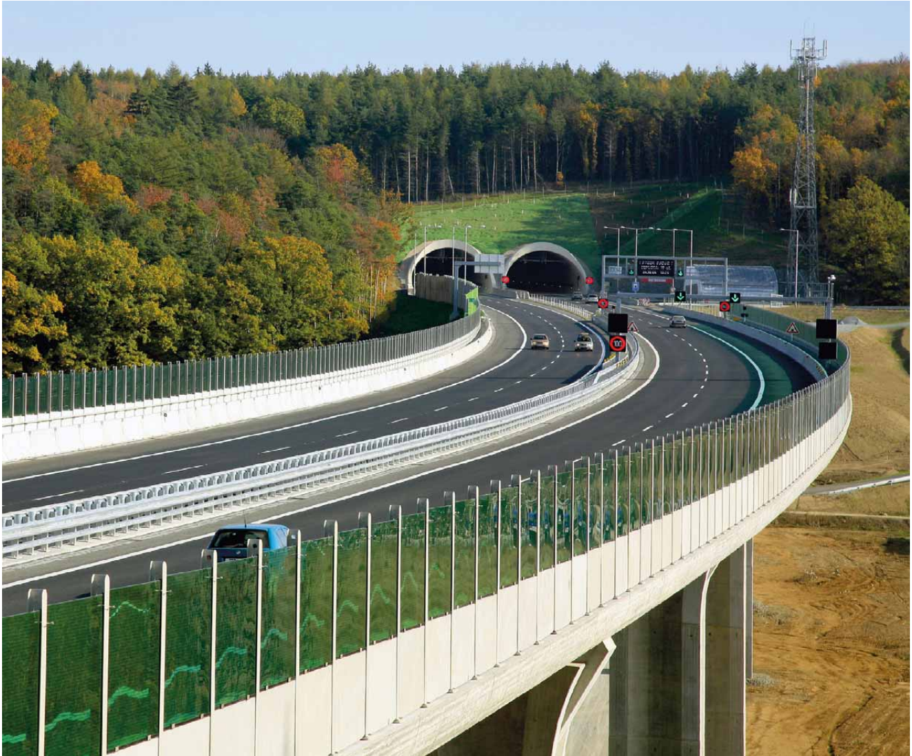
109 Dálnice D5, most přes Úhlovu a tunel Valík
