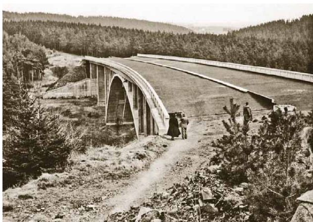
2 Rozestavěný most budoucí dálnice D1 v roce 1956
