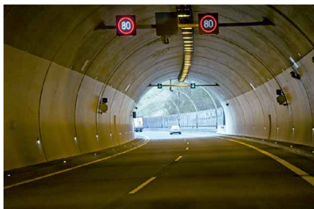
166 Dálnice D8, stavba 0805, tunel Radejčín
