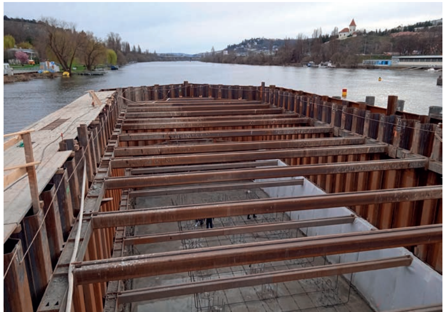
Obr. 8 – Pohled do těsněné štětovicové jímky pilíře P5.
