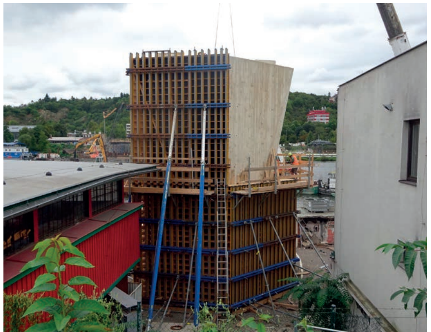
Obr. 5 – Pohled na pilíř P3 od ulice Strakonická.
