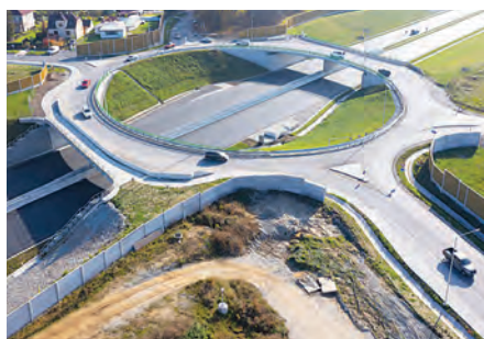
D3 0310/1 OK Hodějovice projektovaná pro případné budoucí napojení sjezdů a využití jako MÚK, vozovky jsou připraveny pro vodorovné značení (podzim 24, ŘSD)
