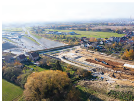
D3 0310/1 poslední podzemní práce před zprovozněním – železobetonový tunel mizí pod zásypy zeminou (podzim 24, ŘSD)
