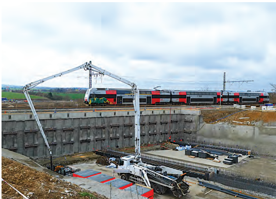
Tady se staví propojení Evropy - Pražský okruh (stavba D0 511). Zajištění stavební jámy tunelu Říčany (Na Vysoké) v km 72,785 kotvenou pilotovou stěnou podél trati Praha - Benešov (ŘSD 03/2026)
