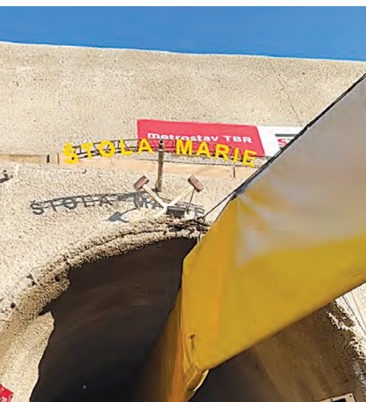
Průzkumová štola Marie pro tunel Kamenná vrata středoevropské D3 se razi od srpna 2025 (ŘSD 01/2026)
