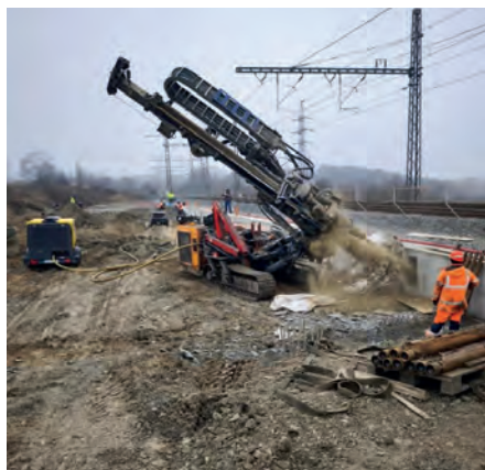
Pražský okruh (stavba D0 511) z Běchovic k dálnici D1. Vrtání kotev první úrovně (PORR 01/2026)
