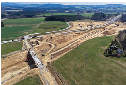
Odpočívka Suchdol na hranici staveb 0312/I a 0312/II. Dnešní I/3 vedoucí stavenišťem bude po otevření dálnice napojena na silnici do Dvořiště (vlevo) a odpočívka dokončena (ŘSD 04/2026)
