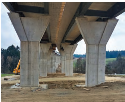
D3 0312/I Estakáda Zalky (SO 211). Pilíře a spodní část nosné ocelové konstrukce (autor)
