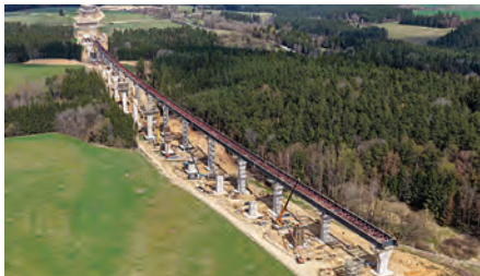
D3 0312/I Estakáda Suchdol (SO 213). Vysunutá ocelové konstrukce na levém mostu (ŘSD 04/2026)
