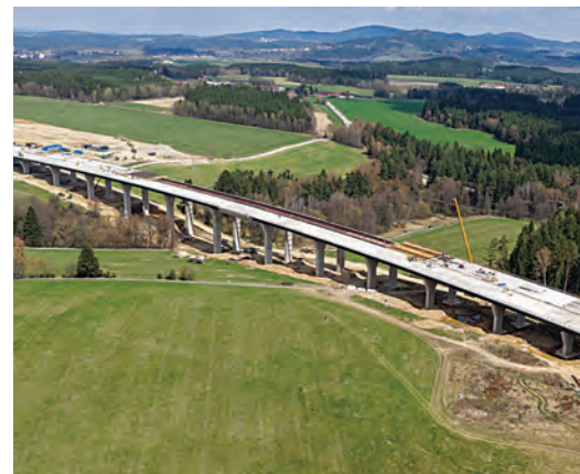
D3 0312/I Estakáda Zdíky (SO 211). Betonáže a pokládka izolací (ŘSD 04/2026)
